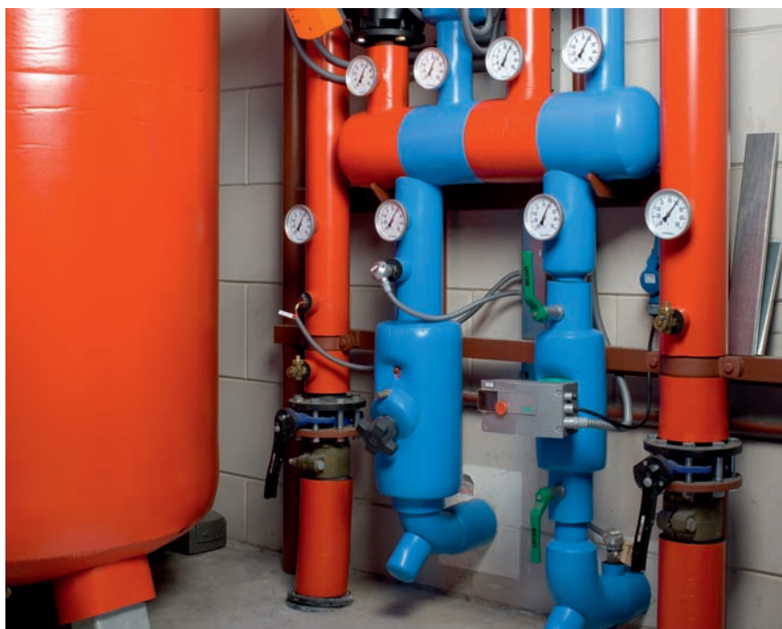
Dämmung in der Haustechnik
