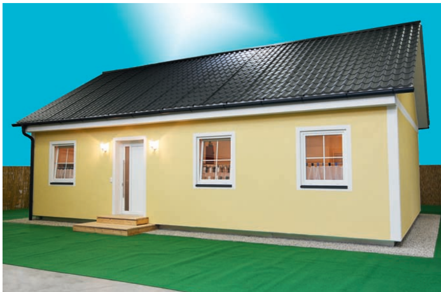
Fertighaus aus standardisierten PUR-Sandwich-Elementen
